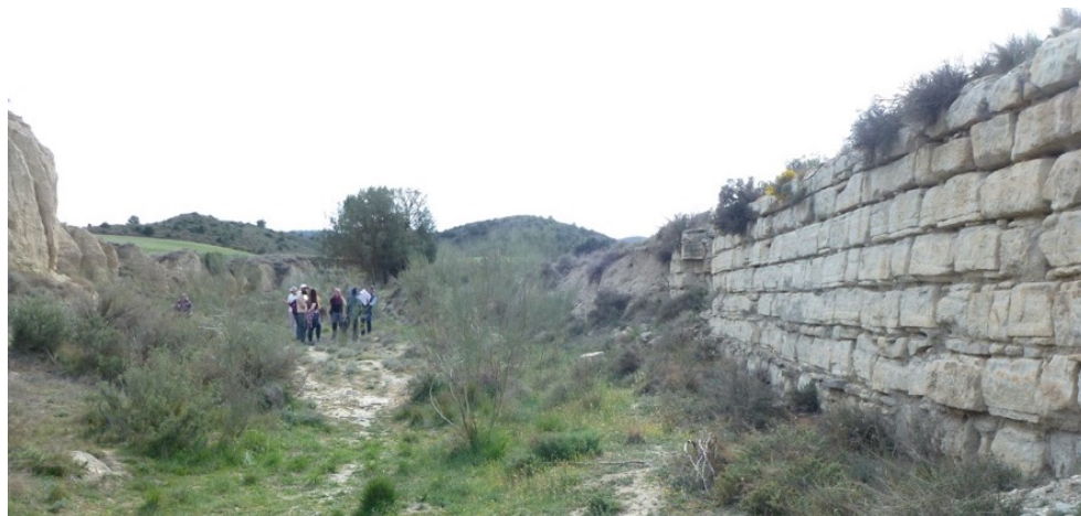
Recorriendo la Val de Zaragoza (Lanaja). De arriba abajo, el azud de Bastarás, los enormes depósitos de sedimentos holocenos de la margen derecha del barranco y el contrafuerte de protección en su margen izquierda.
